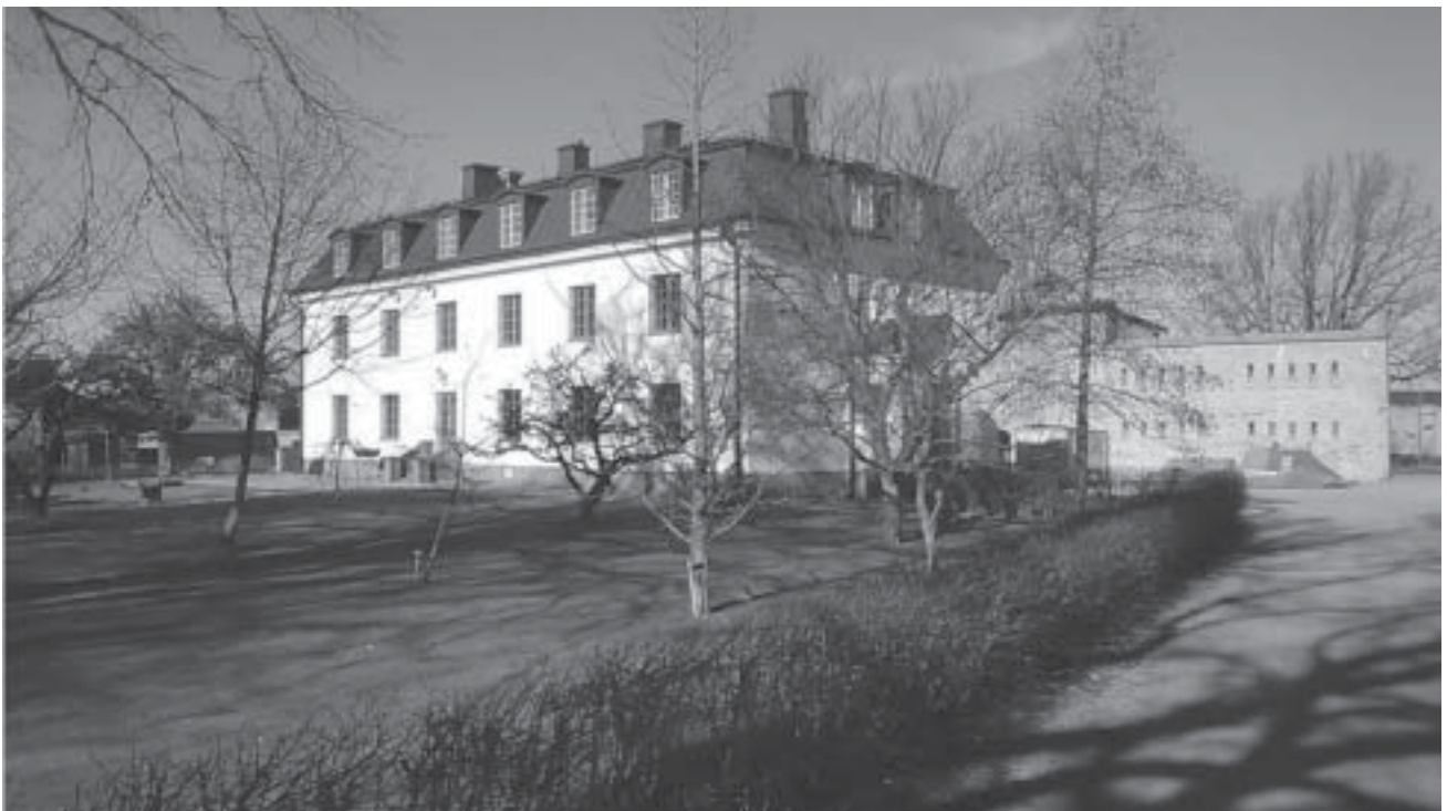
Norra Befälshuset under renovering.
